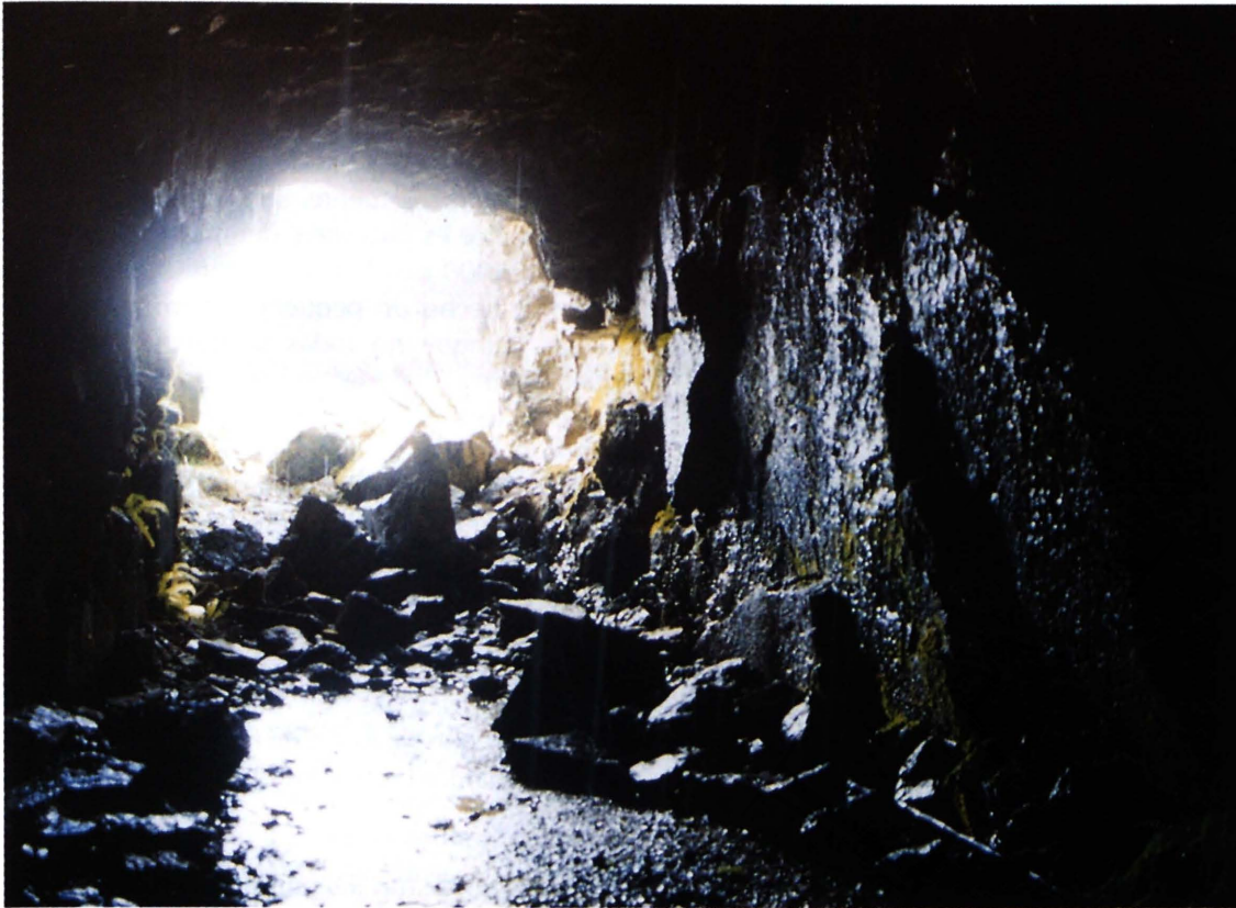
Vista de dentro a afuera de la galería de las Cortes. Esta galería fue excavada hacia 1855.
