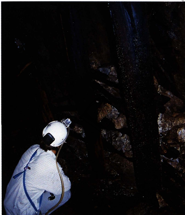
Entibado de madera y "encostillado" lateral en la galería del Puerto de la Cruz Verde, una mina de 1940 que explotaba la "magnesita"
